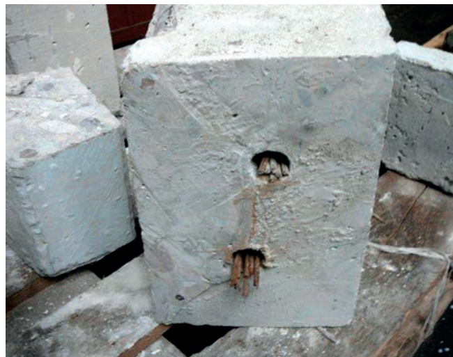
Zkorodovaná výztuž bez injektáže – příčina kolapsu vazníků
