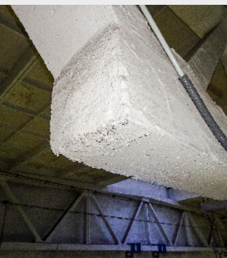
▲ Obr. 6 Dolní kotevní oblasti jsou zpravidla opatřeny ochrannou maltou (6a), nicméně i v tomto případě dochází vlivem koroze ke ztrátě soudržnosti a odloupení ochranné malty (6b, 6c)
