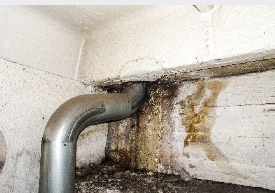
▼ Obr. 8 Poruchy střešních svodů a následné zatékání přímo do horní kotevní oblasti (8a, 8b)
