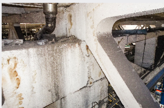
▼ Obr. 8 Poruchy střešních svodů a následné zatékání přímo do horní kotevní oblasti (8a, 8b)
