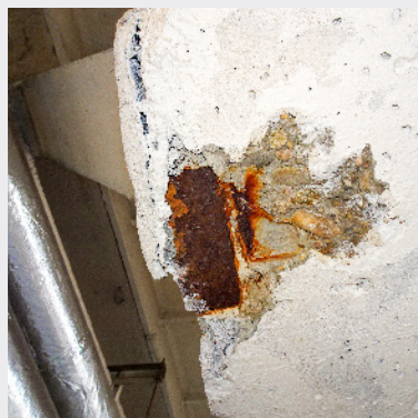
▲ Obr. 6 Dolní kotevní oblasti jsou zpravidla opatřeny ochrannou maltou (6a), nicméně i v tomto případě dochází vlivem koroze ke ztrátě soudržnosti a odloupení ochranné malty (6b, 6c)
