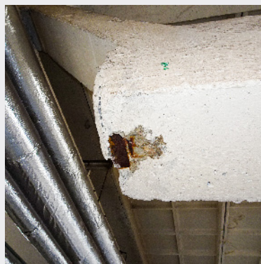
▲ Obr. 6 Dolní kotevní oblasti jsou zpravidla opatřeny ochrannou maltou (6a), nicméně i v tomto případě dochází vlivem koroze ke ztrátě soudržnosti a odloupení ochranné malty (6b, 6c)
