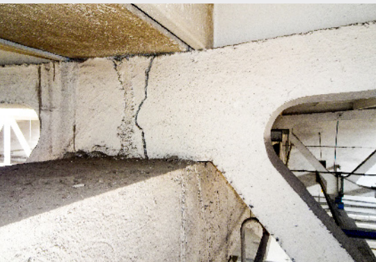
▲ Obr. 5 Vícelodní halové objekty – vyplnění styků příhradových vazníků maltovou zálivkou
