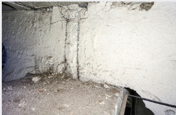
▲ Obr. 5 Vícelodní halové objekty – vyplnění styků příhradových vazníků maltovou zálivkou
