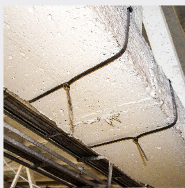
▲ Obr. 7 Styčné spáry segmentů příhradového vazníku (7a) a ukázky porušení těsnosti maltové zálivky trhlinami nebo pozůstatky výdřevy (7b, 7c)
