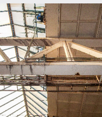
▲ Obr. 7 Styčné spáry segmentů příhradového vazníku (7a) a ukázky porušení těsnosti maltové zálivky trhlinami nebo pozůstatky výdřevy (7b, 7c)
