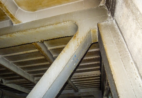
▲ Obr. 4 Jednoduché halové objekty – zneprístupnění čela příhradového vazníku monolitickým průvlakem (4a) nebo prefabrikovaným ukončovacím prvkem (4b)
